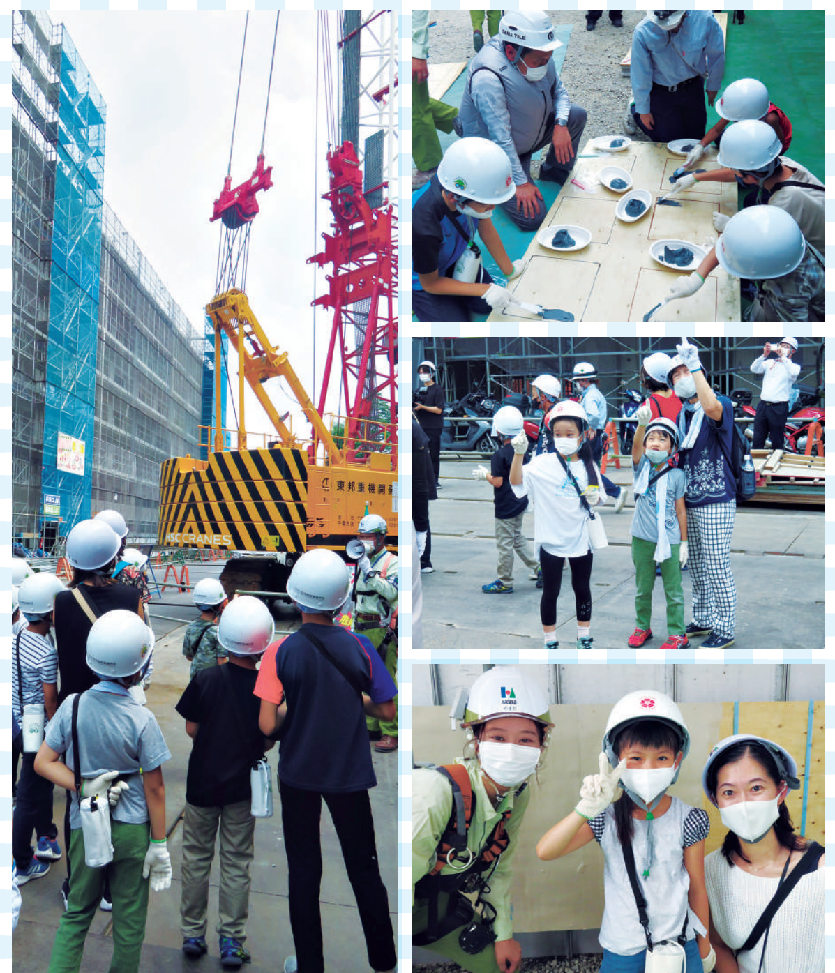
8月24日 (仮称)石神井公園団地建替計画新築工事
