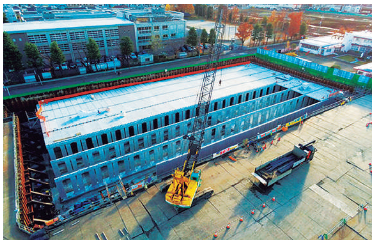
草加松原の雨水貯留施設整備工事
